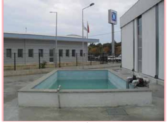
Gümüldür itfaiye binası
