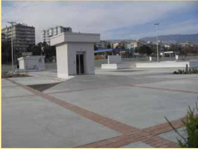
Evka- 3 aktarma istasyonu üst düzenlemesi yapılması
