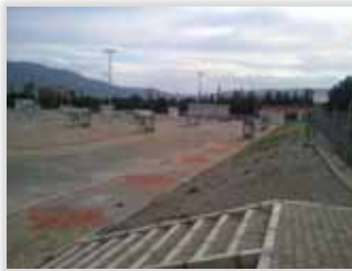
Evka 3 Aktarma İstasyonu Çevre Düzenlemesi
