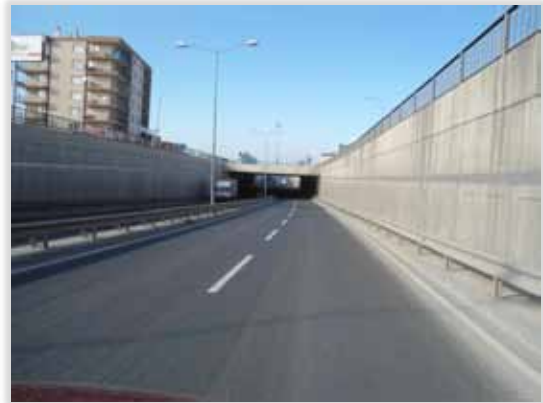
Çiğli Harmandalı Altgeçidi Harç Tipi Asfalt Uygulaması
