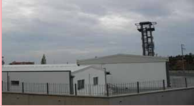
Gümüldür itfaiye binası
