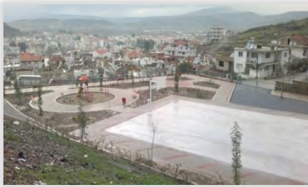
Selçuk Zafer Mah.3044 Sokak Park Çalışması Spor Kompleksi
