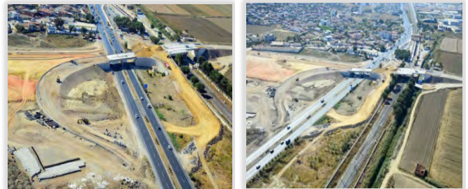
Ulukent Köprülülük Kavşağı
