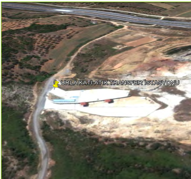
Urla Katı Atık Transfer İstasyonu
