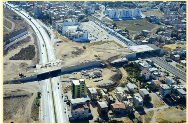
Evka-5 Köprülülük Kavşağı
