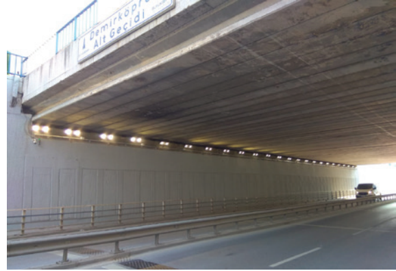
Demirköprü Alt Geçidi
