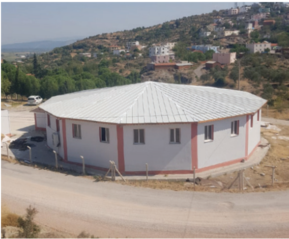
Bergama Tepeköy Mahallesi İbadethanesi Çatı Tadilatı ve Boya Çalışması
