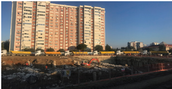
İzmir Opera Binası Yapım Çalışmaları
