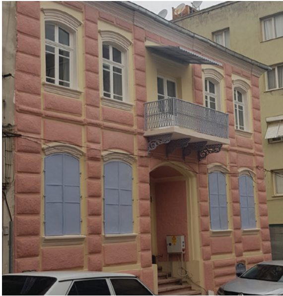
Tire İlçesi 201 ada, 3 parselde yer alan yapının restorasyonu
