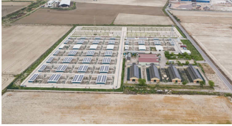
Seyrek Hayvan Barınağı Güneş Enerjisi Santrali
