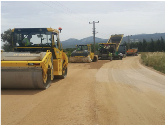
Sathi Kaplama Uygulaması
