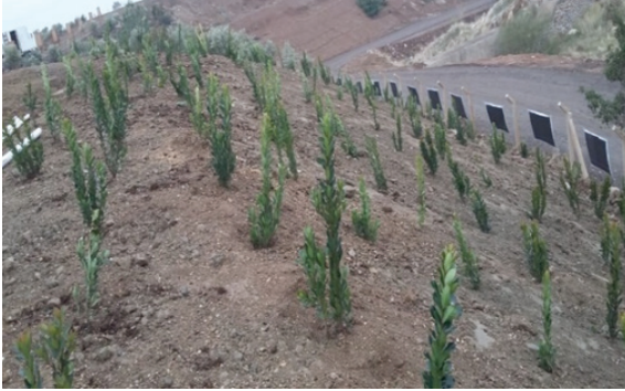
Bornova Şeytan Deresi Hafriyat Depolama Sahası 1.Etap
