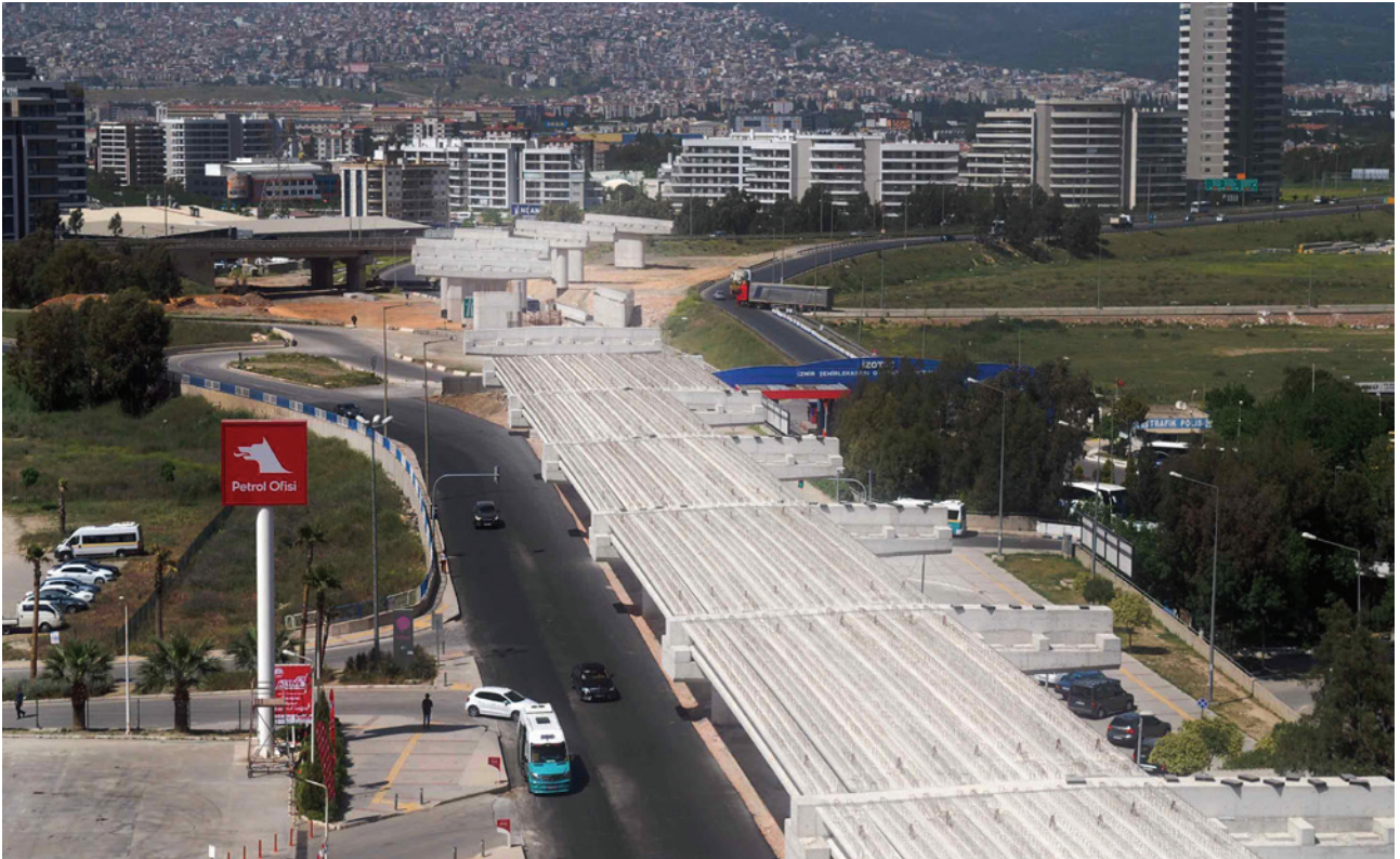
Buca Onat Caddesi ile Şehirler Arası Otobüs Terminali ile Çevre Yolu Arası Bağlantı Yolu Tünel Yapılması ve Viyadük Yapılması
