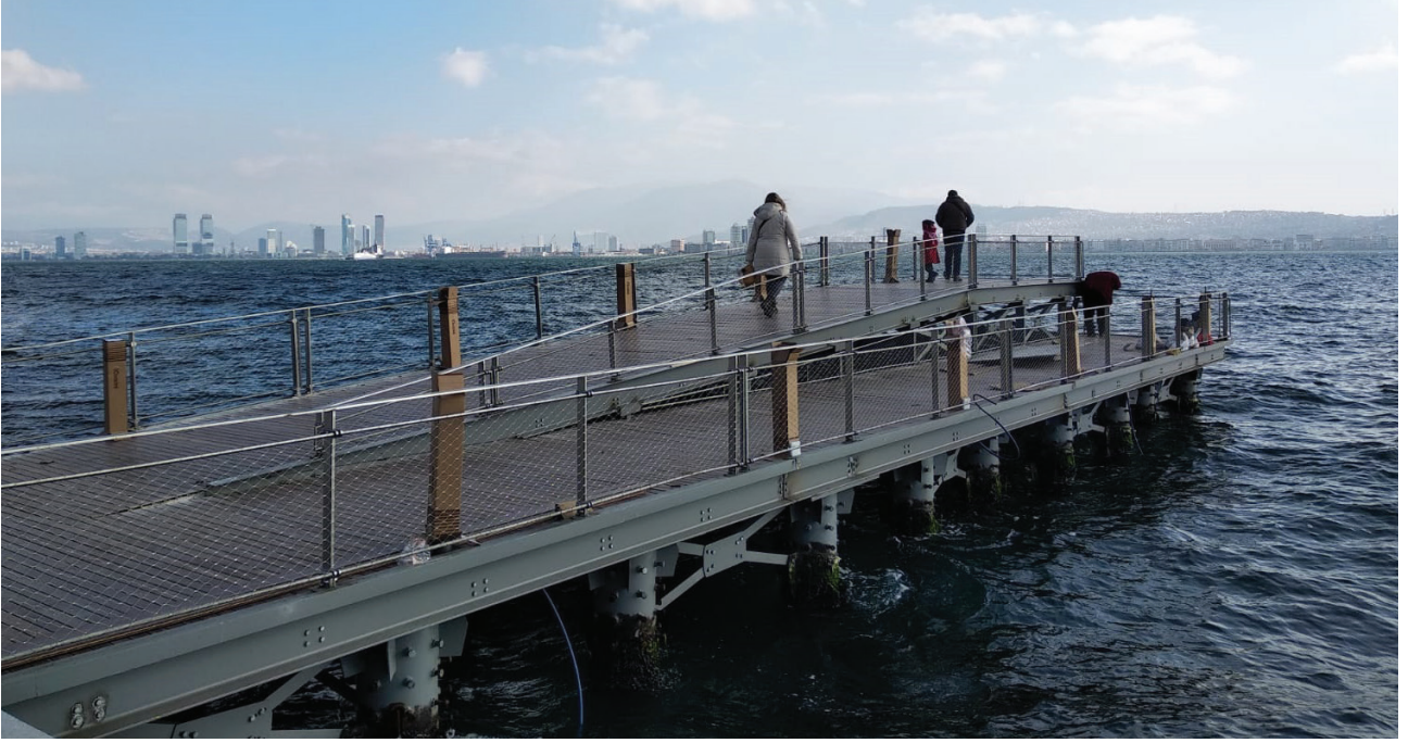
Karşıyaka sahilinde 6 adet ahşap iskele tamamlanması
