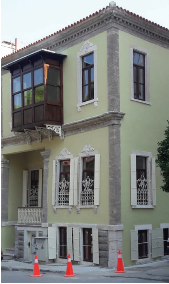
Tire 28 Pafta 1109 Ada 56 Parselde Yer Alan Yapının Restorasyonu Yapılması
