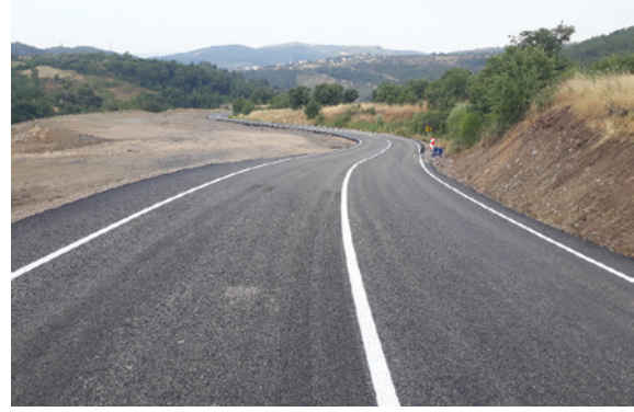
Bornova İlçesi Beşyol Köyü Asfalt Serim
