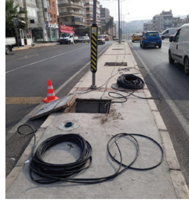
Sinyalize Kavşak Loop Çalışması
