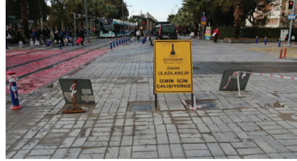
Yayalaştırılmış Bölgede Hareketli Bariyer Sistemi Yapımı
