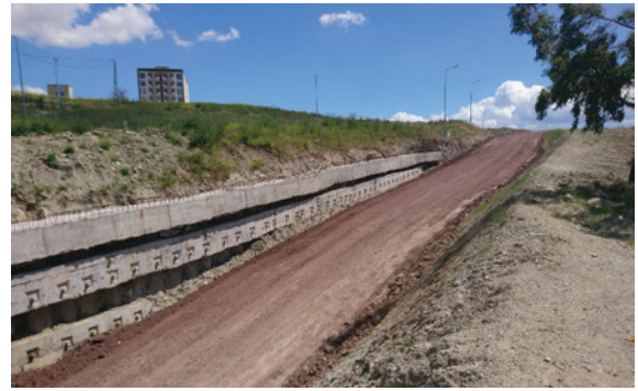
Çiğli Esentepe Mahallesi 8810-1 sokak ve 8050 sokak Devamı Yol Yapılması
