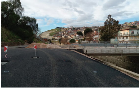
Konak İlçesi Vezirağa Mahallesi Yeşildere 5402-2251 sokaklar Bölgesinde Karayolu Köprüsü
