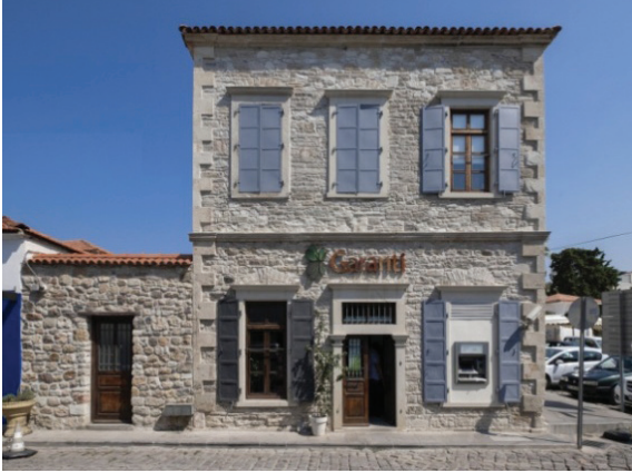
Esaslı Onarım Ödülü Garanti Bankası (Foça)
