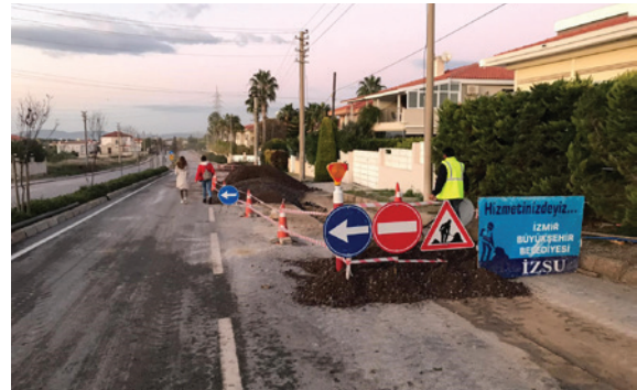
Çeşme İlçesi (İZSU İçmesuyu 2. Etap İş Gece Çalışması)
