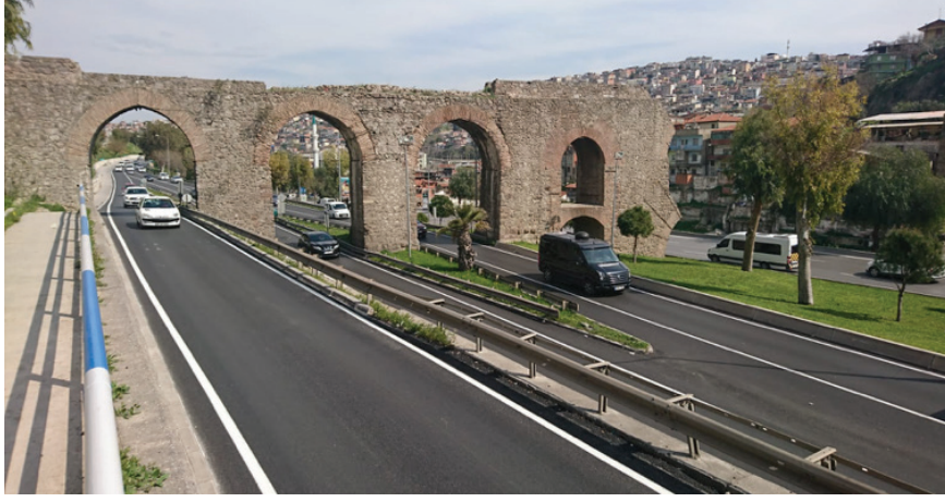
Konak Yeşildere Caddesi Asfalt Serim Yapılması
