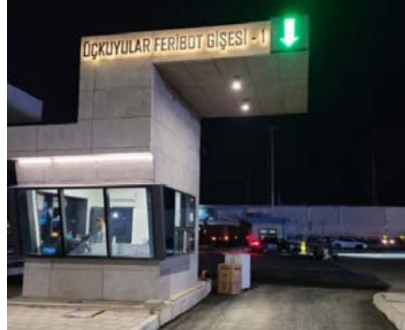
Prefabrik Yolcu Salonu ve Gişe Alımı İş'i
