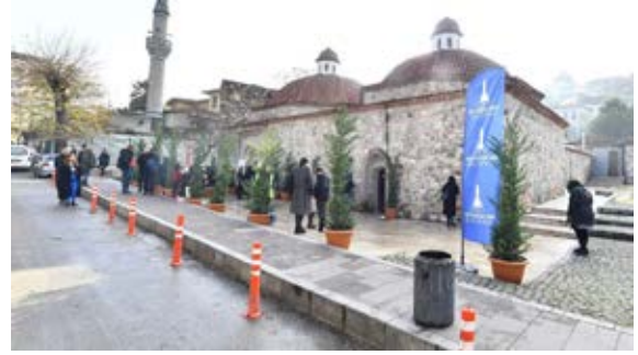
Namazgah Hamamı Basit Bakım Onarım Yapılması İşİ
