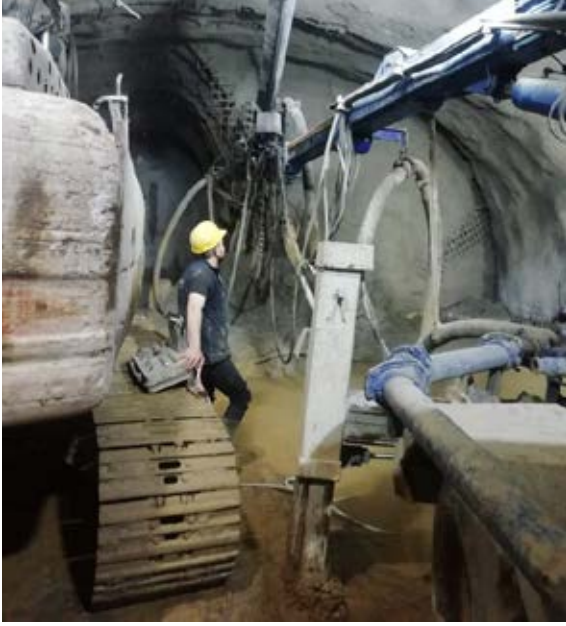
Narlidere Depolama Bağlantı Tünelleri
