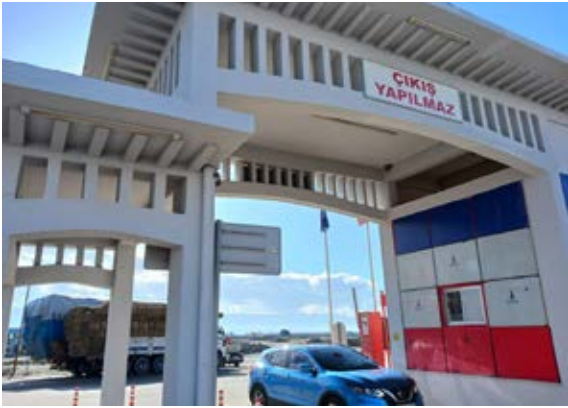
Ödemiş Terminali Genel Boya Tadilat Çalışması
