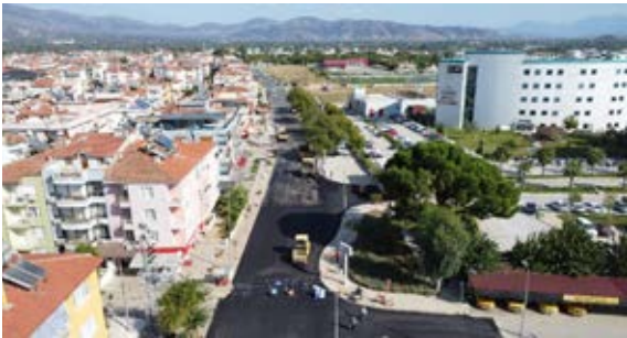
Ödemiş Hürriyet Mahallesi Sıcak Asfalt Serim Çalışması
