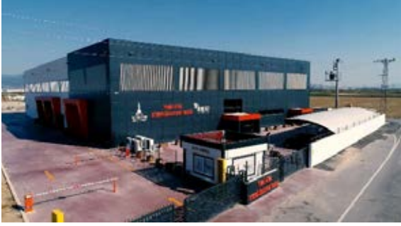
Tıbbi Atık Sterilizasyon Tesisi
