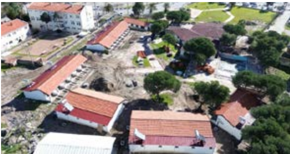
Dikili İlçesi Çandarlı Belediye Sosyal Tesisleri Tadilatı
