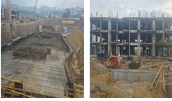
Uzundere III. Yapım Çalışmaları
