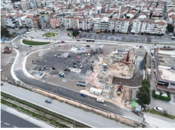
Balçova İstasyonu Üstyapısı
