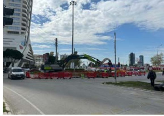
Yağmursuyu Kanal Çalışmaları
