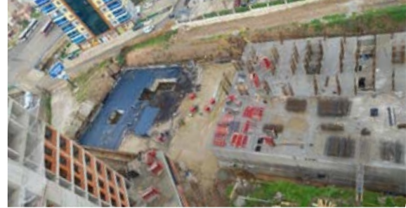
Örnekköy III. Etap B Blok Yapım Çalışmaları
