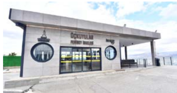
Prefabrik Yolcu Salonu ve Gişe Alımı İş'i
