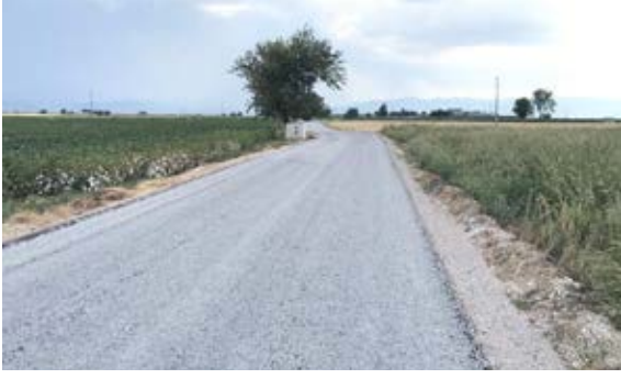
Bergama Alibeyli Mahallesi Sathi Kaplama İşi
