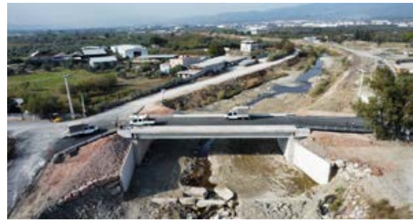
Kemalpaşa Taşıtlı Köprüsü
