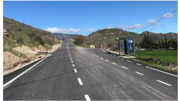
Bergama Tepeköy Mahallesi Asfalt Serim İşi
