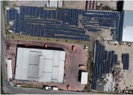
Yağmur Hasadı Projesi Depolar
