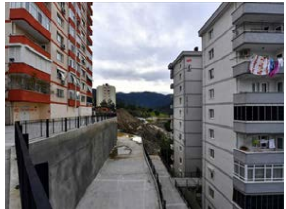
Narlıdere İlçesinde Yıkılan ve Zarar Gören İstinat Duvarlarının Yapılması
