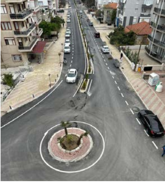
Çeşme Alaçatı Mahallesi Atatürk Bulvarı Düzenleme Çalışması
