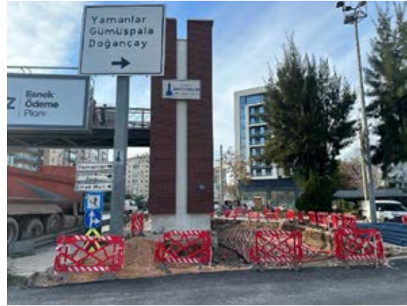
Enerji Temini Altyapı Çalışmaları
