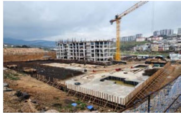
Gaziemir I. Etap Yapım Çalışmaları
