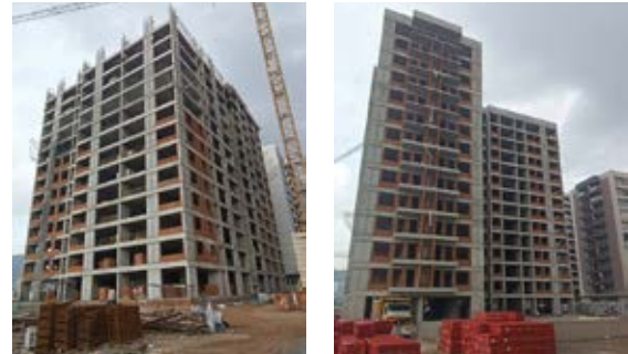
Örnekköy IV. Etap Yapım Çalışmaları
