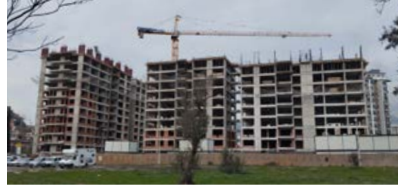
Örnekköy III. Etap A1 ve A2 Bloklar Yapım Çalışmaları
