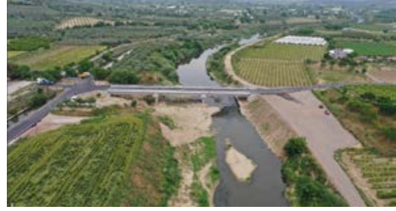
Menemen Hasanlar Taşıtlı Köprüsü
