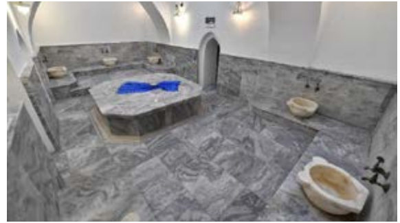
Namazgah Hamamı Basit Bakım Onarım Yapılması İşİ
