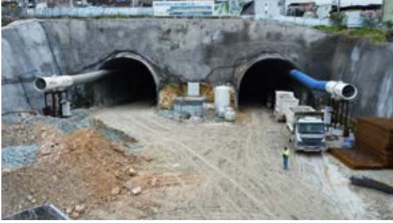
Buca Onat Tüneli İkmal İnşaatı Bağlantı Yollarının Yapılması
