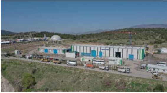
Bergama Entegre Katı Atık Yönetim Tesisi
