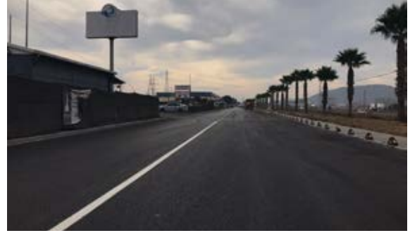
Aliğa Samurlu Mahallesi Asfalt Serim İşi
