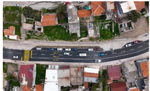
Konak Gürçeşme Caddesi, Asfalt Serim Yapılması
