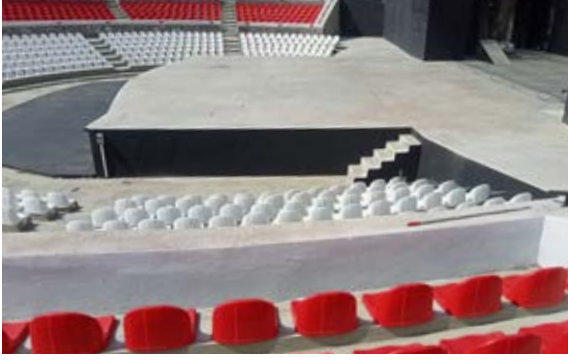
Fuar Kültürpark Açık Hava Tiyatrosu Genel Bakım Onarım Yapılması
