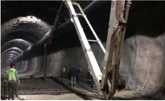
Buca Onat Tüneli İkmal İnşaatı Bağlantı Yollarının Yapılması
