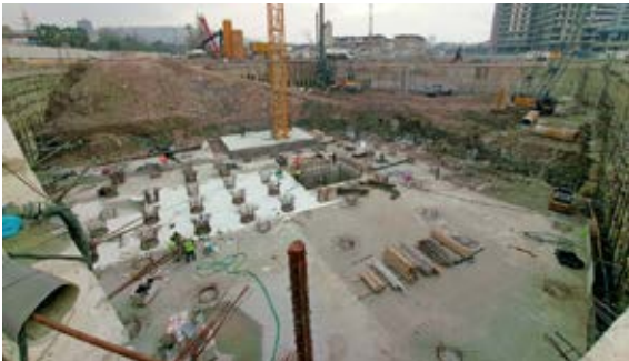
Ege Mahallesi I. Etap Yapım Çalışmaları
