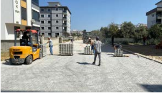
Torbalı Yedi Eylül Mahallesi Kilit Parke İmalatı
