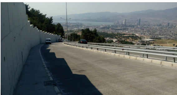
Buca Toros Şahintepesi ile Çamkule Bağlantı Yolu İyileştirme Uygulanması İşi
