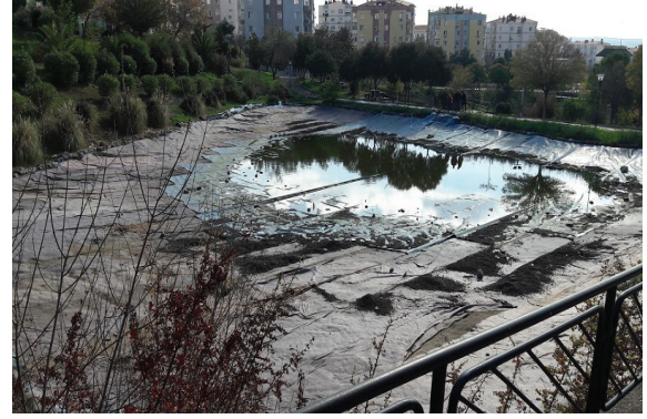
Buca Yedigöller Rekreasyon Alanında Yenileme Yapılması işi
