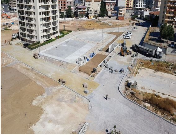
Metropol Alan İçerisinde Bulunan Ulaşım Yollarında Bakım - Onarım - Tadilat Yaptırılması
