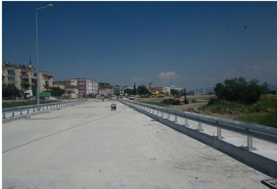
Bergama İslamsaray Mah. Taşıt Köprü Yapılması İşisi Kapsamında Taşıt Köprüsü ve Bağlantı Yolu Yapılması İşleri
