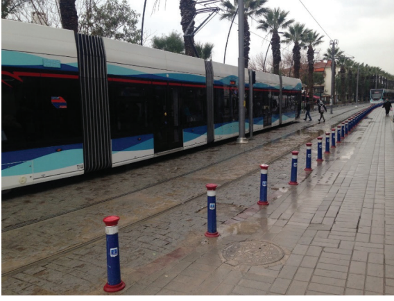
Karşıyaka İlçesi Tramvay Güzergahı Yol ve Düzenlenmesi İşi
