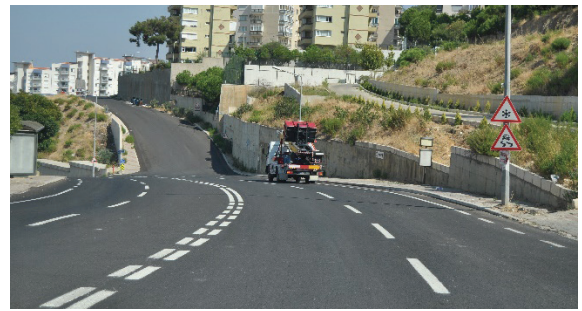
Yol Çizgi Uygulaması Çalışmaları
