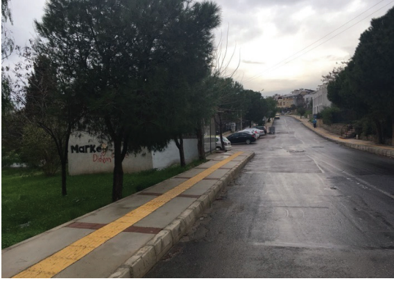
Çiğli Ahmet Taner Kışlalı Mahallesi Muhtelif Sokaklarda Tretuvar Düzenlenmesi İşi
