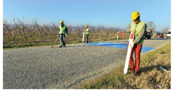
CTP Yol Kenar Dikmesi Uygulama Çalışmaları
