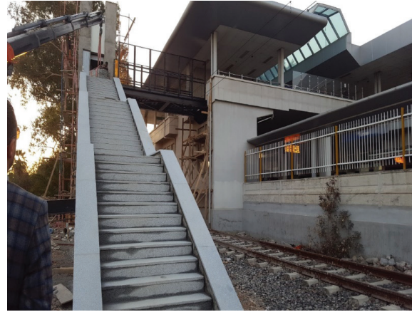
Bayraklı İlçesi Turan İstasyonu Güney Bölgesi Yaya Üst Geçidi Yapılması
