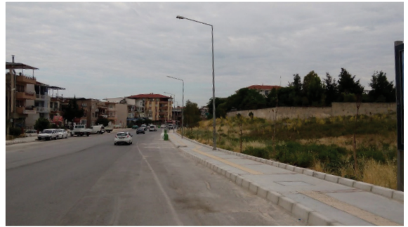
Buca Yavuz Sultan Selim Caddesi Yol ve Tretuvar Düzenlenmesi İşi
