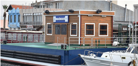
Urla İskelesi Geçici Yükseltilmiş Yolcu Platformu
