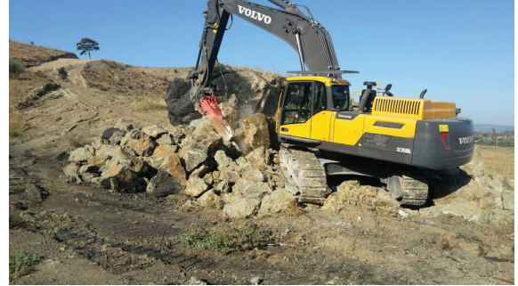
Menemen Atatürk Mah. 1526 Sokak Kazımpaşa Mahallesi 1214 Sokak Bağlantı Yolu İmarlı ve Üretim Yol Açma
