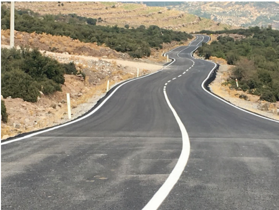
Bornova Karaçam Köyü İle Kayadibi Köyü Arası Bağlantı Yolu
