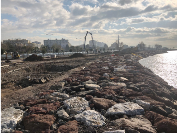
Bostanlı Sahili Çevre Düzenlemesi Yapım Aşaması
