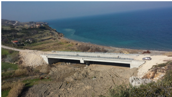
Karaburun Bozköy Taşıt Köprüsü Yapılması
