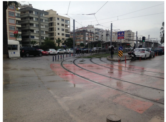
Karşıyaka İlçesi Tramvay Güzergahı Yol ve Düzenlenmesi İşi
