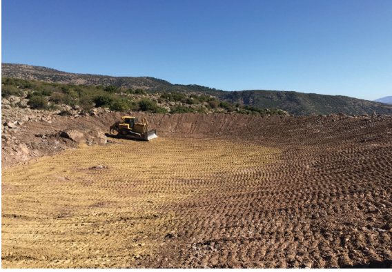
Bornova Eğridere Hayvan İçmesuyu Göleti
