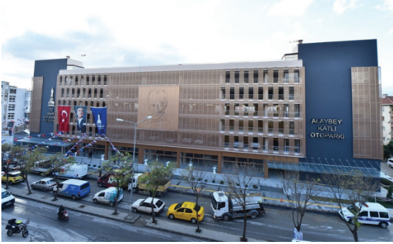
Alaybey Katlı Otopark Çevresi Düzenlemesi İşi
