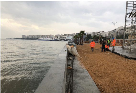
Karşıyaka Anıt Çevresi Su İçi Betonları Yapım Aşaması
