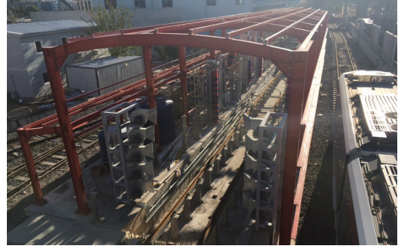
Otomatik Tren Yıkama Ünitesi Tamamlanmıştır
