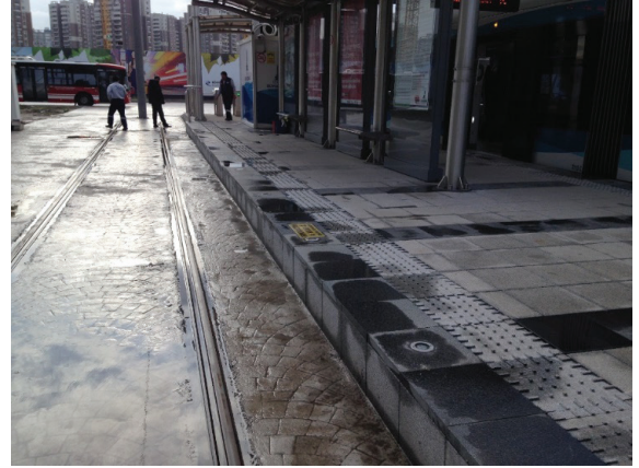
Tramvay Güzergahında Durak İçi Granit Taş Kaplama Yapılması İşi
