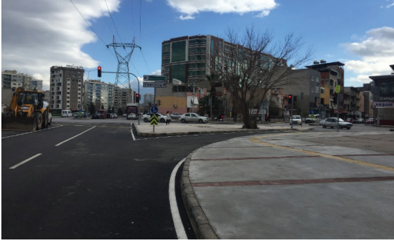
Bornova İlçesi Diva Evleri Önü Düzenleme Yapılması İşi
