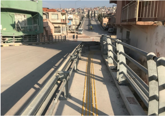
Konak Yenidoğan Mahallesi 1127 Sokak Taşıt Üst Geçidi Tretuvar ve Bağlantı Yolu İstinat Duvarı Yapılması İşi
