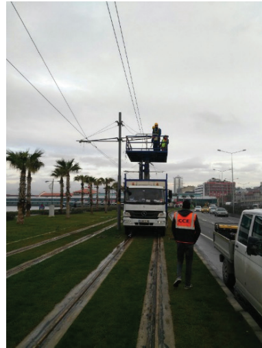
Deniz Feneri Sokak ve Mustafa Kemal Sahil Bulvarı Katener Teli Çekimi Çalışmaları
