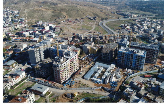
Uzundere Kentsel Dönüşüm Projesi 1. Etap Yapım
