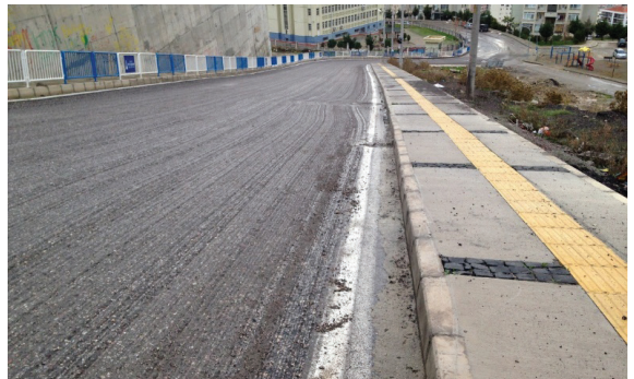
Çiğli Evka – 5 Kaldırım ve Yol Düzenlemesi İşi
