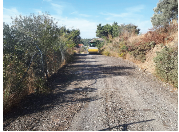
Buca Belenbaşı Mahallesi 3015-3020 Sokak Bağlantı Yolu Yol Tesviyesi
