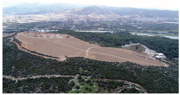
Güzelbahçe Yelki Hafriyat Depolama Sahası
