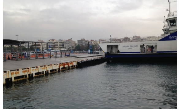
Bostanlı İskelede Yanaşma Rampasına Çelik İmalatı Yapılması İşi
