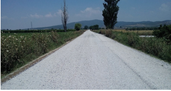
Torbalı Aslanlar Mahallesi Değirmenaltı Sokak
