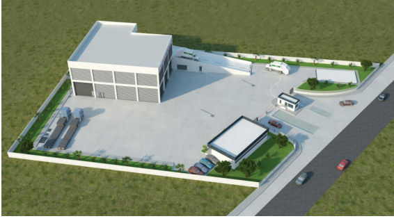
Selçuk Katı Atık Transfer İstasyonu
