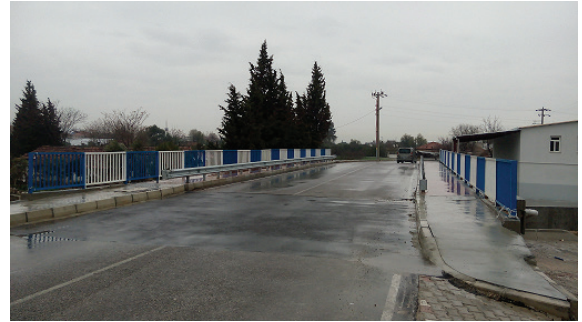
Menderes Gölçükler Taşıt Köprüsü Bağlantısı Kaldırım ve İstinat Duvarı İşi
