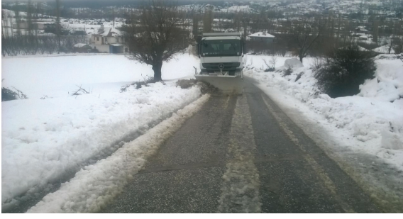
Kiraz Taşlıyatak Mahallesi Karla ve Buzlanma ile Mücadele İşleri
