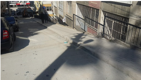
Konak Hatay 149 Sokak Beton Yol ve Kaldırım Düzenlenmesi İşi
