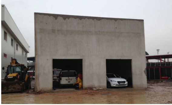
Devam Eden Trafo Merkezi İnşaat Çalışması
