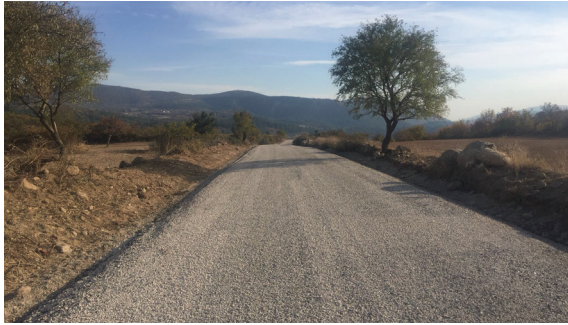
Sathi Kaplama Uygulaması
