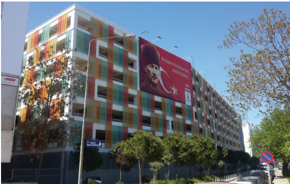
Kahramanlar Kapalı Otoparkı cephe yenilemesi
