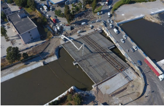
Meles Deresi Köprüsü İmalat Çalışmaları
