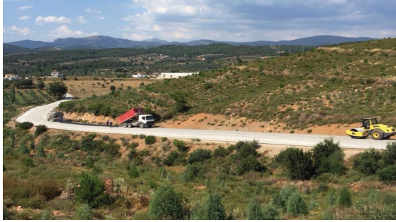
Sathi Kaplama Uygulaması
