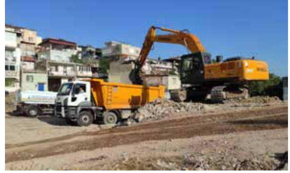
Konak İsmet Paşa Mahallesi
