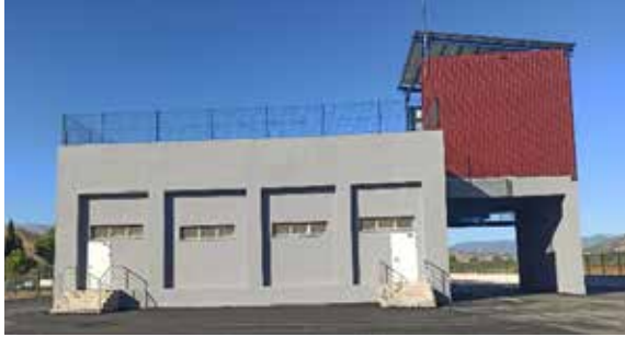
Ödemiş Katı Atık Transfer İstasyonu
