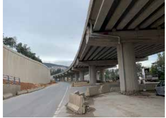
Buca Onat Caddesi ile Şehirlerarası Otobüs Terminali ve Çevre Yolu Arası Bağlantı Yolu Yapılması (Birinci Etap) İkmal (Viyadük)
