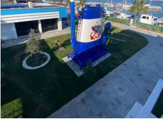
Balçova İzmir Marina İçi Zemin İyileştirme Beton İmalatları Düzenleme
