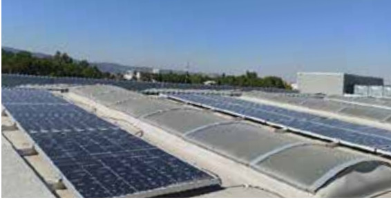
Çaybaşı İtfaiye Binası GES Kurulumu
