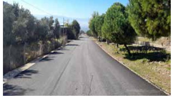
Ödemiş Birgi Irmakağızı Yolu Sıcak Asfalt Serim Çalışması
