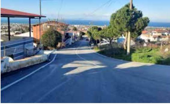
Güzelbahçe Payamlı Caddesi 726 Sokak Asfalt Serim Çalışması
