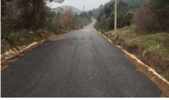
Bergama ilçesi Alacalar - Çamköy - Narlıca Arası Asfalt Serim Yapılması
