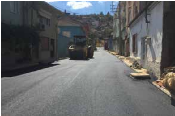
Tire Cumhuriyet Mahallesi Debboy Caddesi Sıcak Asfalt Serim Çalışması
