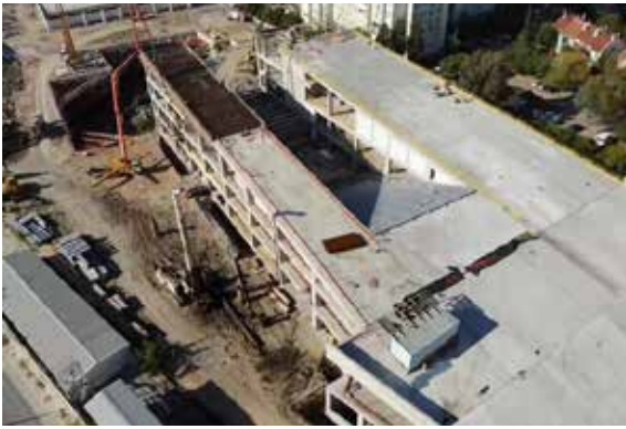
İzmir Opera Binası İnşaatı
