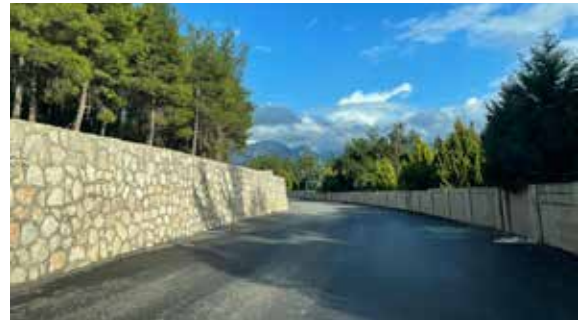
Buca Kaynaklar Mezarlık Yolu Asfalt Serim Çalışması
