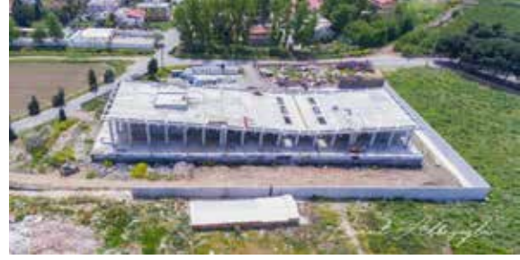
Selçuk İlçe Garajı İkmal İnşaatı
