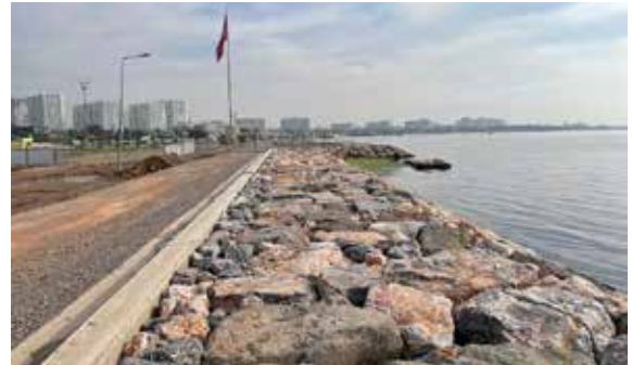
Mavişehir Kıyı Rehabilitasyonu
