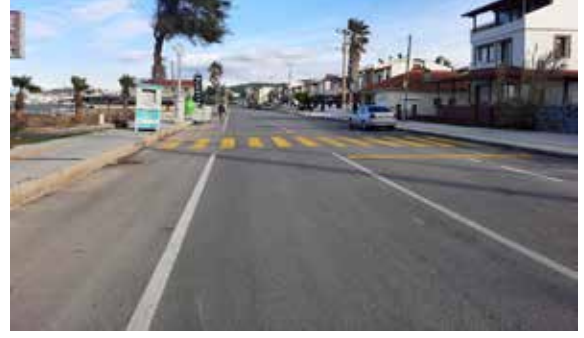
Urla Neyzen Tevfik Caddesi Asfalt Serim Çalışması
