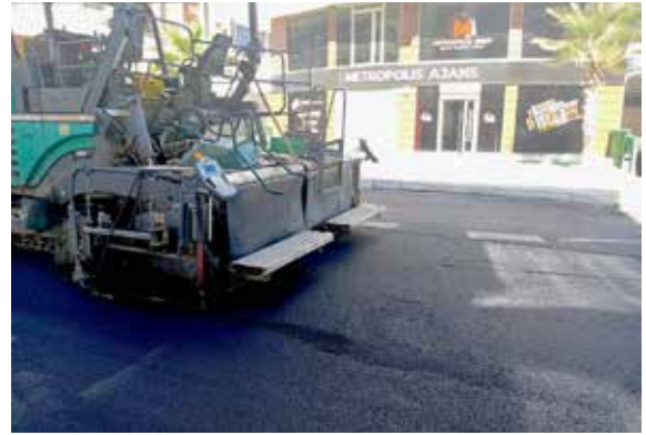
Torbalı Alpkent 1008-1009-1042 Sokak Sıcak Asfalt Serim Çalışması
