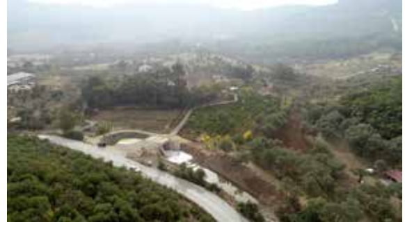
İl Genelinde Muhtelif Yerlerde Menfez ve Yaya Köprüsü Yapılması
