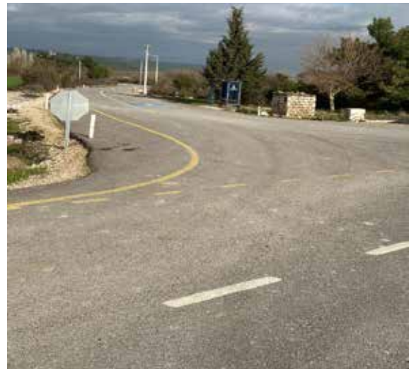
Kınık ilçesi Musacalı - Kaşıkçı Arası Asfalt Serimi
