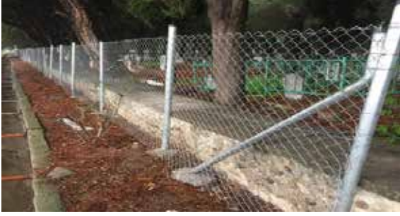
Mezarlık Çevresi Tel Çit Uygulaması
