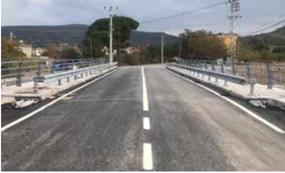
Dikili ilçesi Bademli Mahallesi 1.Sokak Üzeri Karayolu Köprüsü
