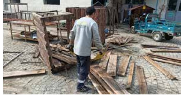
Köprü ve Gözetleme Kulelerin Bakım Onarım Çalışmaları
