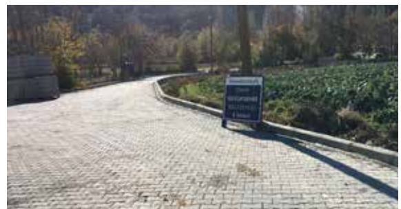
Ödemiş Gölcük Mahallesi Kilit Parke İmalatı
