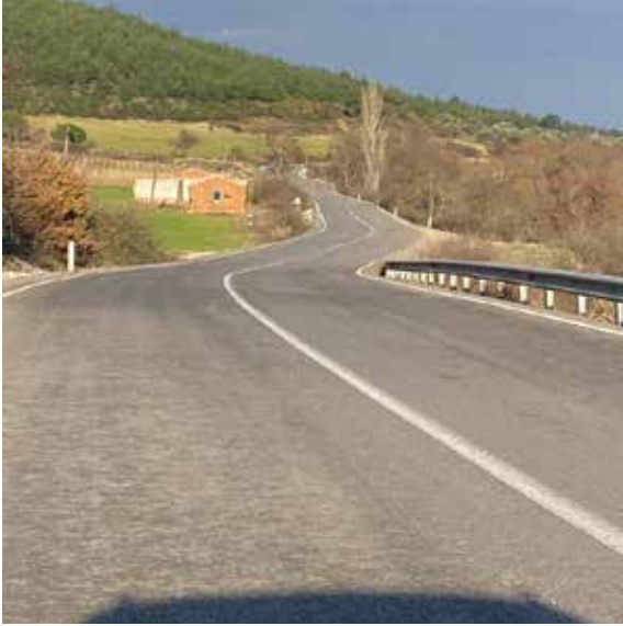
Kınık ilçesi Elmadere Mahallesi Asfalt Serim Yapılması
