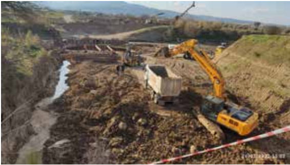
Menemen Hasanlar Taşıt Köprüsü
