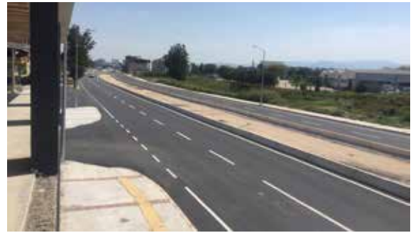
Çiğli Ata Sanayi 8780/1 Sokakta Yol Tretuvar Düzenlemesi
