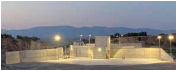
Kınık Katı Atık Transfer İstasyonu
