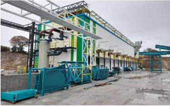
Bergama Entegre Katı Atık Yönetim Tesisi
