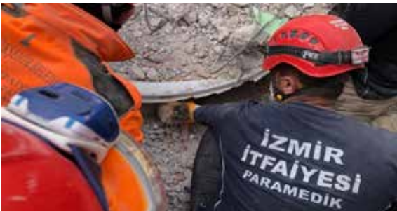
Enkaz Kaldırma Çalışmaları
