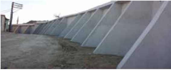
Fore Kazıklı Betonarme İstinat Duvarları
