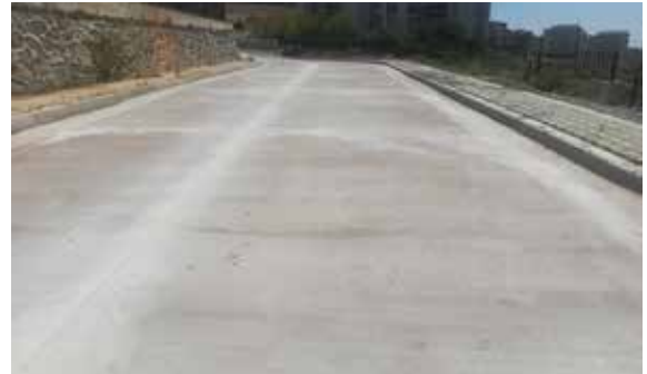
Bayraklı Doğançay Mezarlığı Beton Yol ve Kaldırım Yapılması
