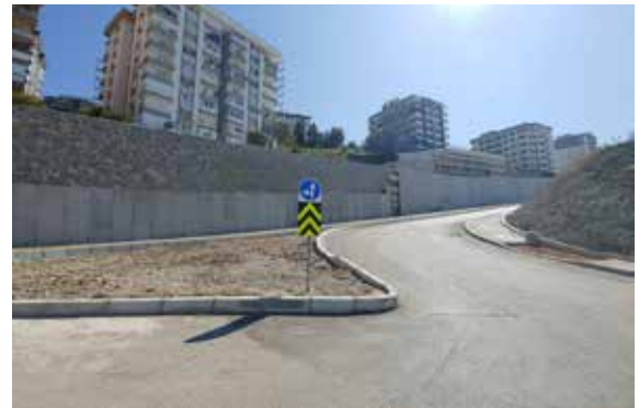
Metropol Alan İçerisinde Bulunan Ulaşım Yollarında Bakım Onarım Yapılması
