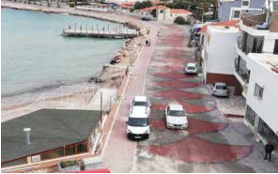
Karaburun İlçesi Mordoğan Sahil Kenarı Yol ve Kaldırım Düzenlemesi İşİ
