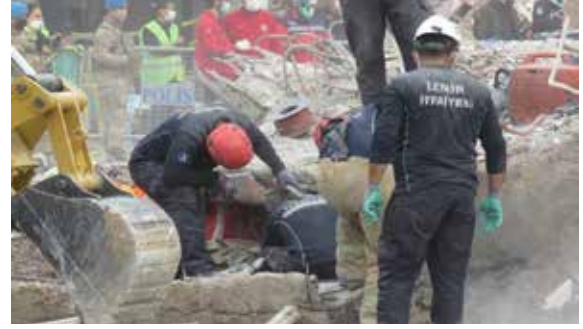
Enkaz Kaldırma Çalışmaları
