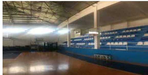
Karabağlar İlçesi İzmirspor Kulübü Bakım Onarımı
