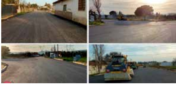
Bakım Onarım Çalışmaları
