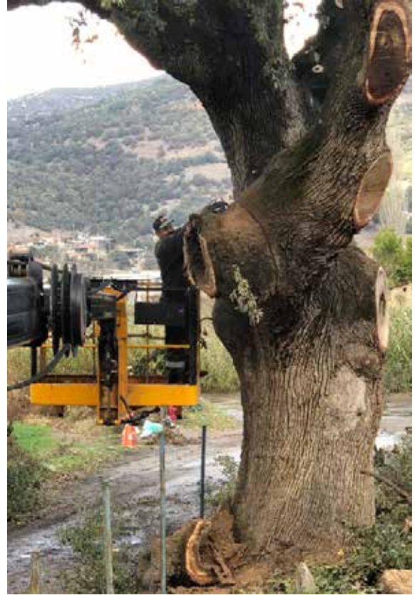
Asırlık Ağaç Restorasyonu
