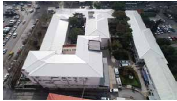
Eşrefpaşa Hastanesi Çatı Yenileme Çalışması
