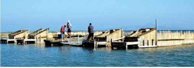
Homa Dalyan kuzuluğu kargı ve ağaç kazıklar, sıcak galvaniz kaplamalı demir ızgaralar
