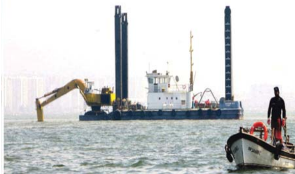
Ragıp Paşa dalyan duvarı, yıkım ve temizleme işlemleri
