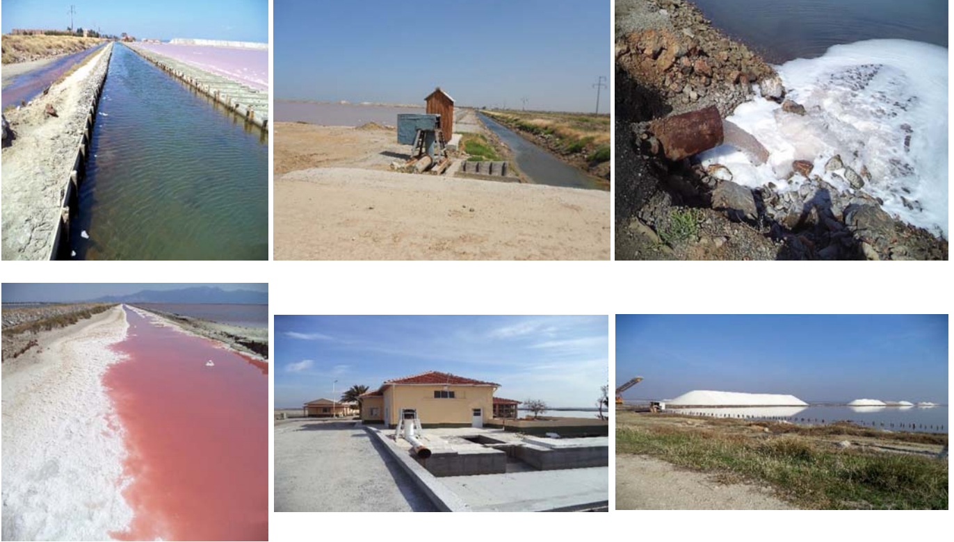
Çamaltı tuzlası deniz suyu temini pompaları ve iletim/tahliye kanalları
