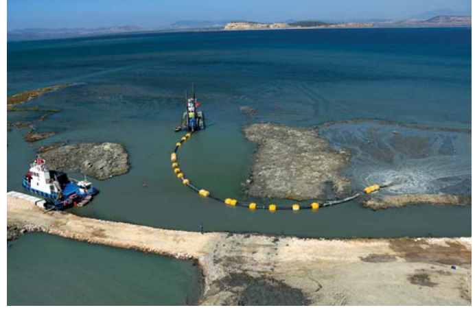
Homa Lagünü'nde derinleştirme çalışmaları
